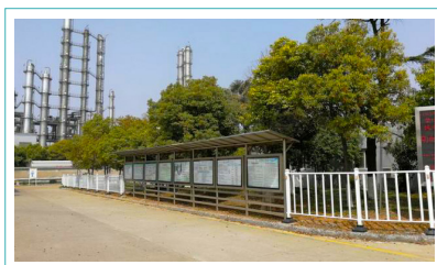
江苏某化工项目
