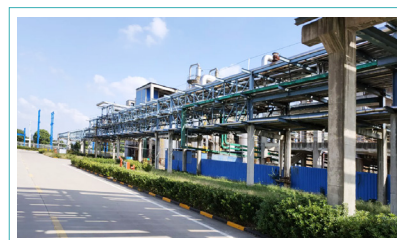
江苏某化工项目
