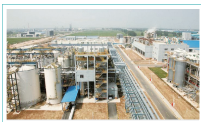
江苏某化工项目
